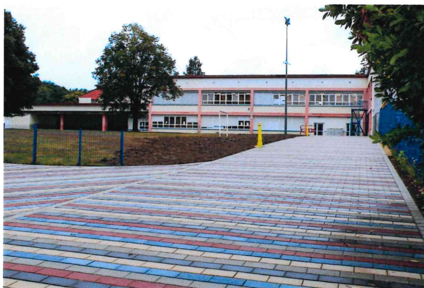
Réalisation d'un parvis et des accès sécurisés de l'entrée des écoles Félix Midy
