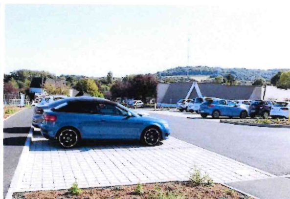
Réalisation nouveau parking
