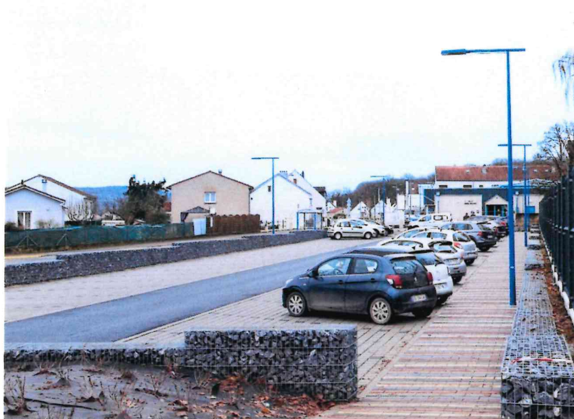
Réalisation du nouveau parking des écoles Félix Midy
