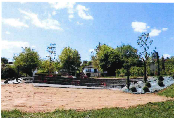
Travaux de l'Agora
