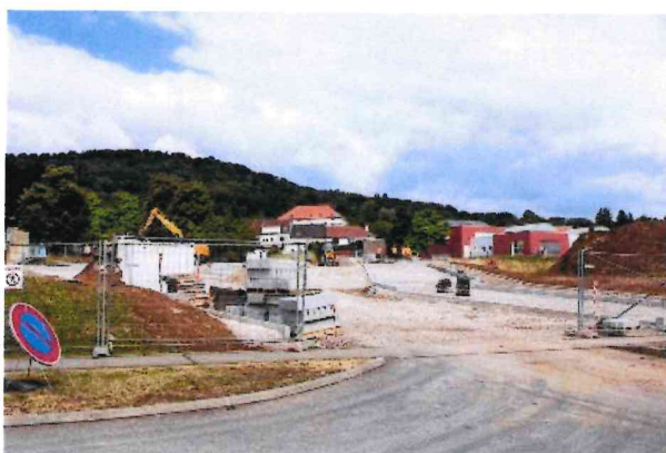
Travaux nouveau parking
