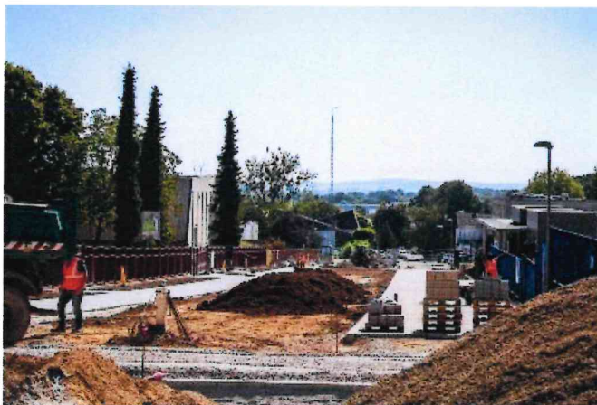
Travaux du Parvis Rue Migette
