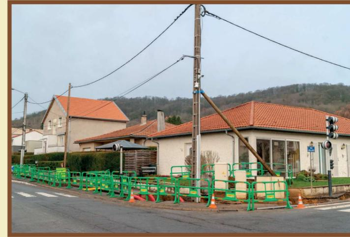
Il a été décidé de consolider et de soulager l'effort sur ce poteau pour stabiliser l'ensemble, le temps de faire des travaux de remplacement et d'éviter tout danger.
